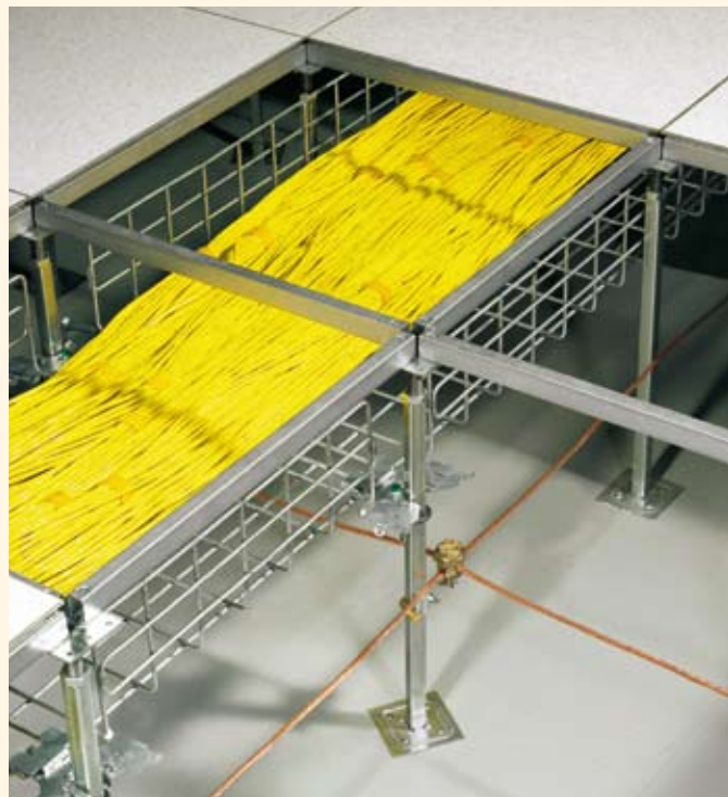
Прокладка кабелей под фальшполом (система GridRunner компании Panduit)
