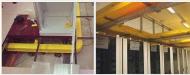
**Рис. 3.** Основная и резервная кабельные трассы имеют маркировку разного цвета
